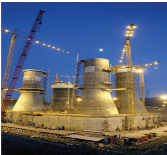
Рис. 2. Основание МЛСП «Пильгун-Астохское-Б» в стадии постройки
