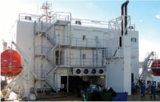
Рис. 7. Установка с помощью портального крана надстройки кабелеукладчика «Мэри Аура»
