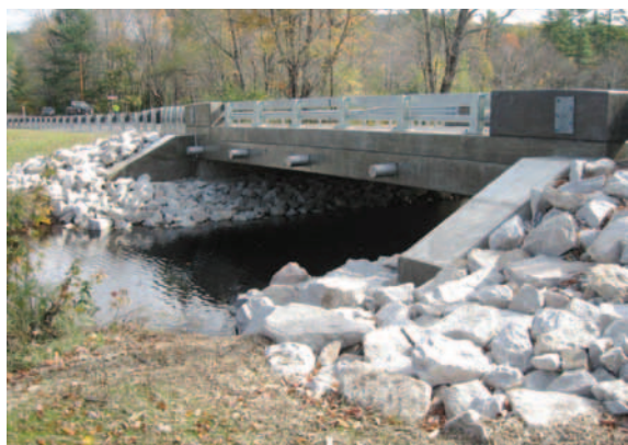
Рис. 1. Общий вид Little Pond Bridge, Route 302, Fryeburg, Maine
