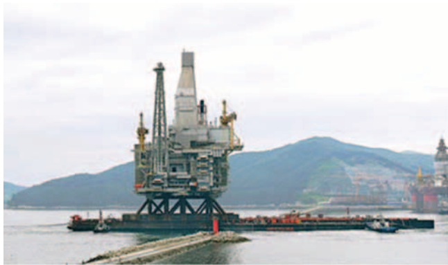
Рис. 1. Транспортировка верхнего строения платформы «Лунская-А» с силовой рамой на барже
