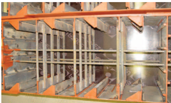
Рис. 8. Плоское поперечное армирование сталебетонной балки
