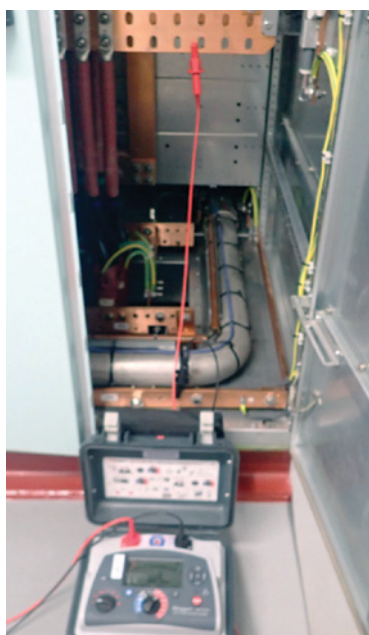
Рис. 11. Измерение сопротивления изоляции обмотки статора ГЭД высоковольтным мегаомметром
