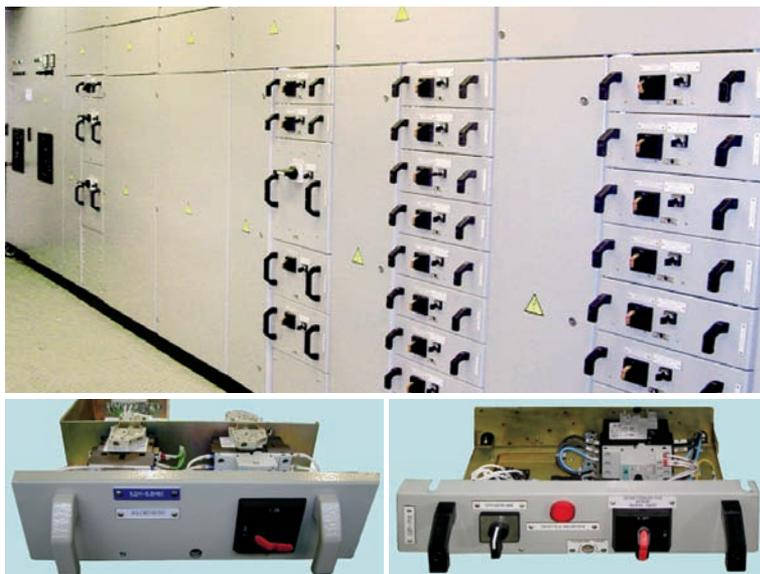
– одно распределительное устройство с местами под два модуля для питания потребителей с током до 2500 А для напряжения 0,4 кВ и 0,6 кВ.
