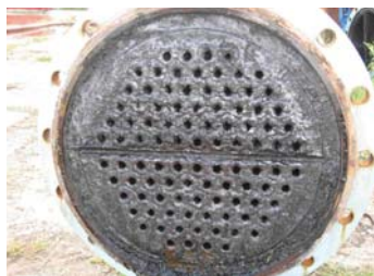
Рис. 2. Загрязнения трубного пространства кожухотрубного теплообменника
