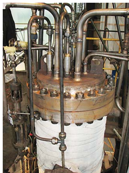
Рис. 2. Парогенератор с компенсатором объема (без теплоизоляции)
