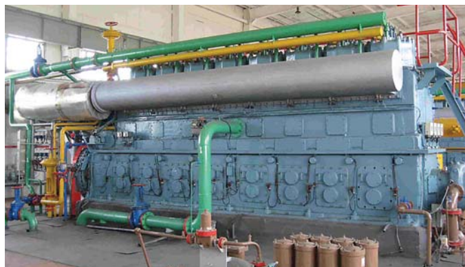
Рис. 1. Поршневой газомотокомпрессор ГМК 8М
