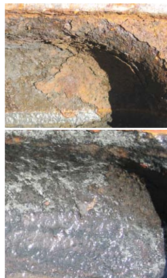
Рис. 5. Крышка АВО ДЭГа до и после очистки ( \delta = 3–5 мм) (коррозионные, солевые и органические отложения).
