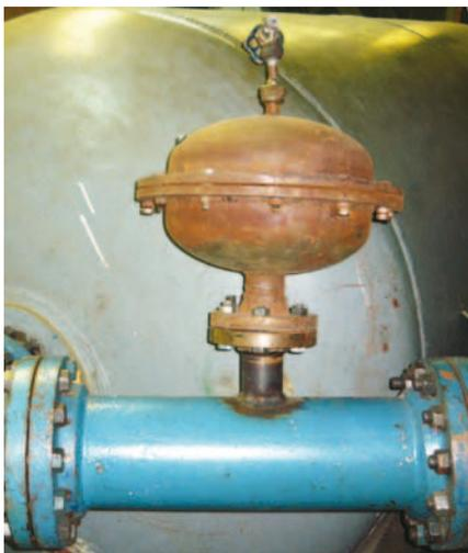
Рис. 1. Резонатор Гельмгольца, установленный в трубопроводной системе
