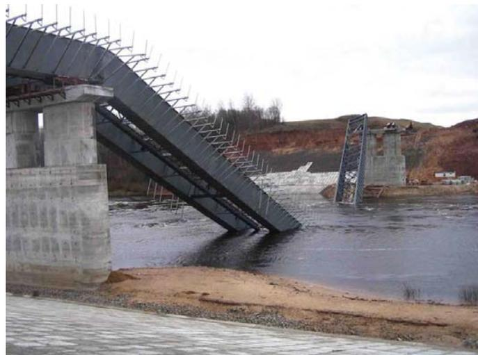
Рис. 7. Крушение главного пролета моста через реку Западная Двина под Витебском
