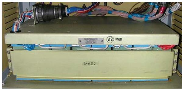
Рис. 2. Аккумуляторный отсек АБП с никель-кадмиевыми АБ
