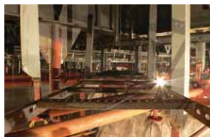
Слесарно-сварочные работы по установке элементов крепления кабельных трасс
