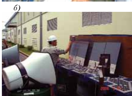
Рис. 5. Проведение испытаний по нанесению защитных покрытий: а – проверка поверхности стали; б – нанесение защитных покрытий
