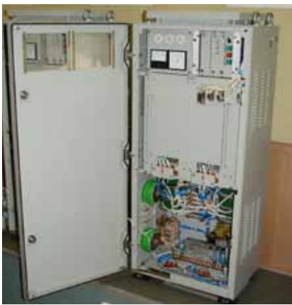
Рис. 4. Статический преобразователь PU (СРТ) второго поколения
