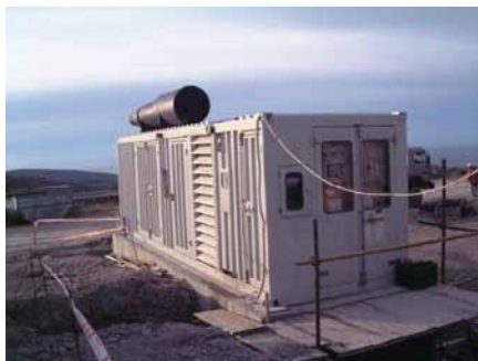
Решение резервного электроснабжения объекта на базе дизель-генераторных установок в модульном контейнерном исполнении
