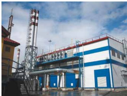
Энергоцентр – решение автономного энергоснабжения завода
