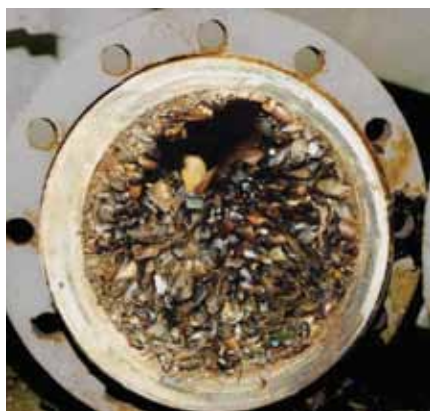
Трубопровод, заросший ракушками
