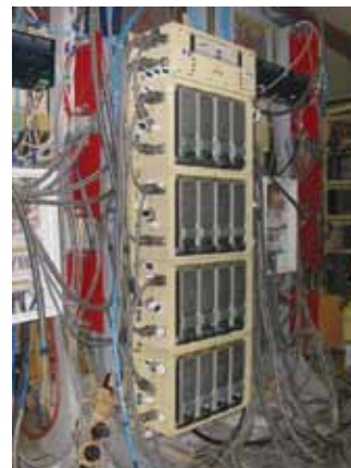
Рис. 3. Бескорпусной АПС в составе АБП во время испытаний на электротехническом стенде НПО «Аврора»: а – установка АПС в отдельный вывешенный на лонжерон блок коммутации (К) АБП, б – соединение блока К на общем лонжероне с преобразующими блоками АБП, в – АБП в сборе (АПС встроен в верхнюю часть прибора)
