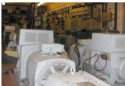
Рис. 2. Типовое электрооборудование испытательного стенда
