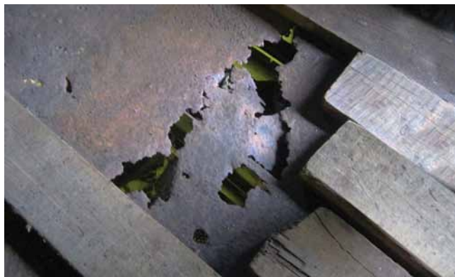
Рис. 1. Состояние главной палубы после снятия цементной стяжки
