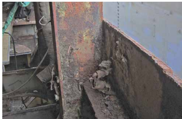
Рис. 2. Состояние бортовой обшивки и набора в районе иллюминаторов
