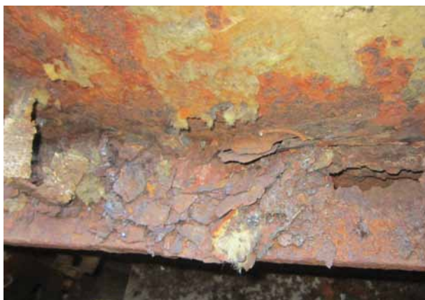
Рис. 3. Состояние бортового набора под иллюминаторами
