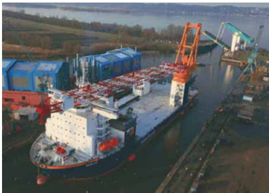
Рис. 10. Строительство современного судна для нужд ветроэнергетики на верфи «Pella Sietas Shipyard»
