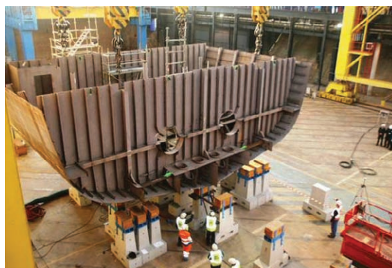
Начало строительства головного корвета пр. GOWIND 2500 для ВМС Египта
