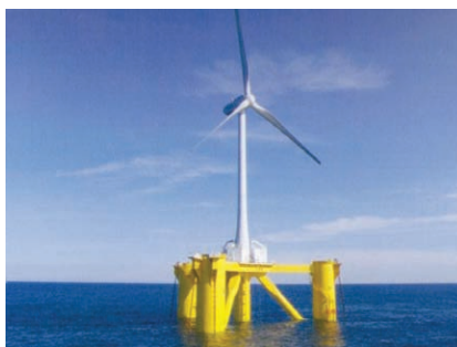
Рис. 25. Полуогруженная плавучая платформа с ветрогенератором
