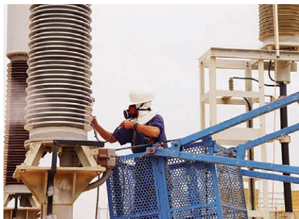
Нанесение покрытия
