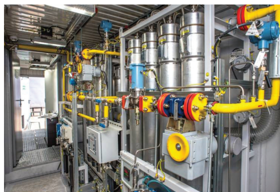
Рис. 8. Мембранная азотная установка Заполярного НГКМ (отсек с воздухоразделительными мембранными модулями)
