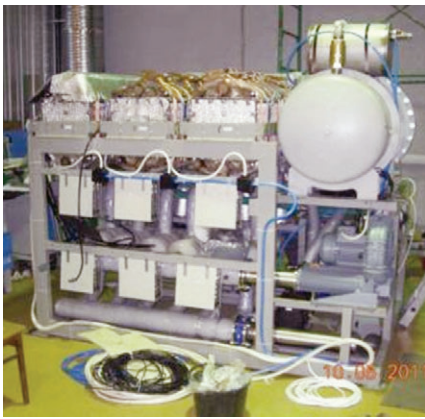
Гибридная энергоустановка МГЭУ-60
