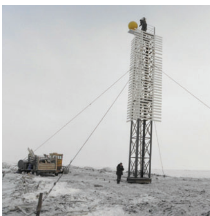
Рис. 8. Ремонт навигационного знака Муостах-Южный с установкой АИП, 2014 г., море Лаптевых, бухта Тикси
