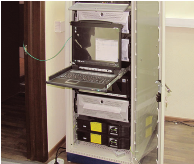
Рис. 5. Пример шкафа вычислительного одной из систем БЭС разработки АО «Кронштадт Технологии»
