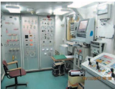
*Пост управления глубоководными водолазными спусками*
