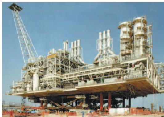
**Рис. 20. Посадка мегаблочной конструкции ВСП на ОТУ**
