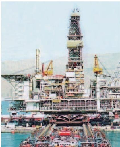
Рис. 16. Опорно-транспортное устройство: а – протяженной конструкции; б – точечной конструкции
