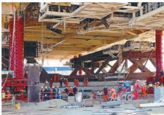
**Рис. 19. Заводка протяженных ОТУ под опорную платформу ВСП**
