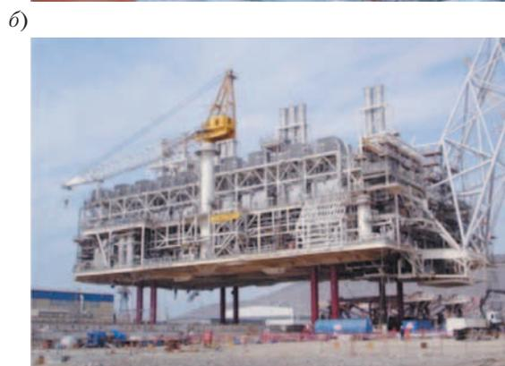
**Рис. 18. Подъем верхнего строения газокompрессорной платформы с помощью восьми гидродъемников: а – монтаж гидродъемников «Push-up-System»; б – общий вид ВС газокompрессорной платформы, поднятого на высоту 13 м**
