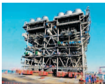
Рис. 4. Пример погрузки и перевозки блоков завода СПГ в Китае
