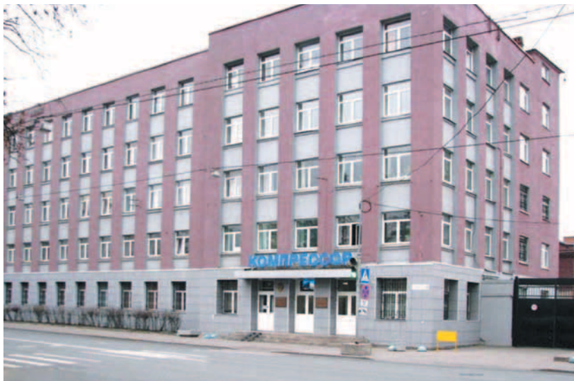
Главное здание «Акционерного общества «Компрессор»
