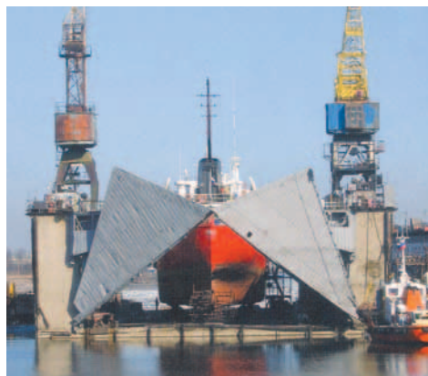
Рис. 2. Железобетонный плавучий док грузоподъемностью 4000 т, построенный в 1933 г.
