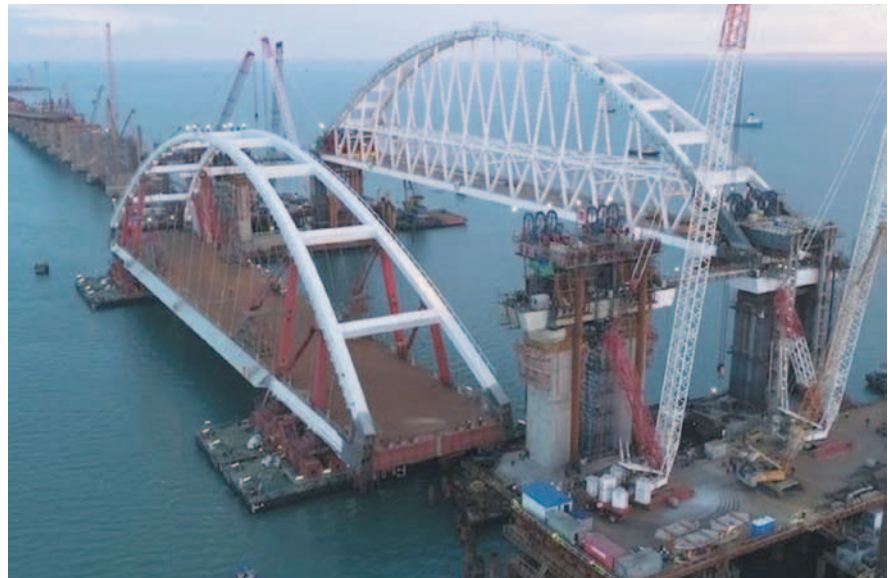
Рис. 7. Установка железнодорожной и автомобильной арок Крымского моста через Керченский пролив
