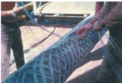
Рис. 19. Установка сетчатого захвата на гибком трубопроводе
