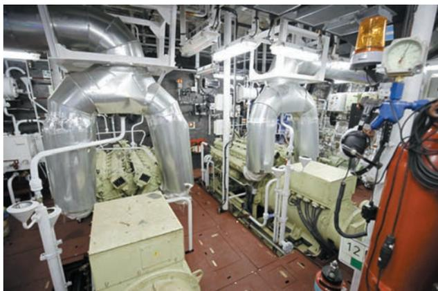
Рис. 12. Расположение главных двигателей CHD622V20 в машинном отделении катера-торпедолова пр. 1388нзт
