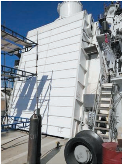
Шеф-монтаж телескопических ворот вертолетного ангара на заказе 112 пр. 22100 «Океан» АО «Зеленодольский завод имени А. М. Горького»
