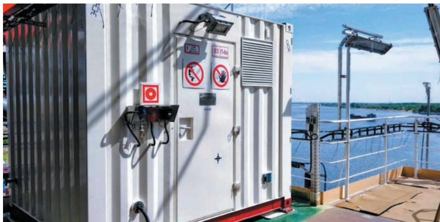
Рис. 2. Блочная воздушная станция BVKC-900 на платформе месторождения им. В. Филановского
