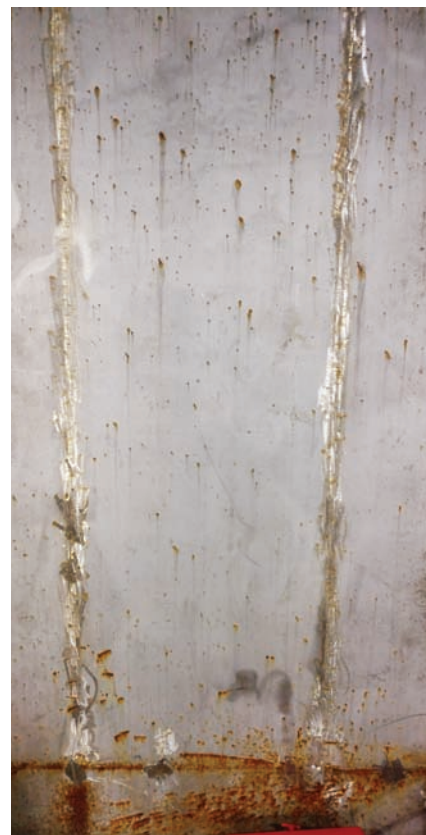
Рис. 1. Нержавеющая сталь марки 03X17H14M3 со следами питтинговой коррозии
