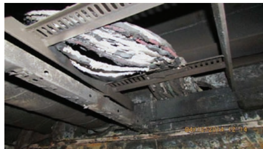
Рис. 3. Последствия пожара в каюте морского буксира СБ-921
