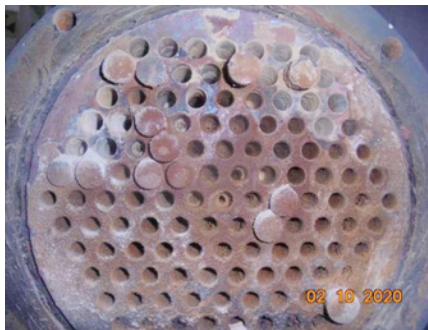
Рис. 2. Паровой конденсатор во время эксплуатации
