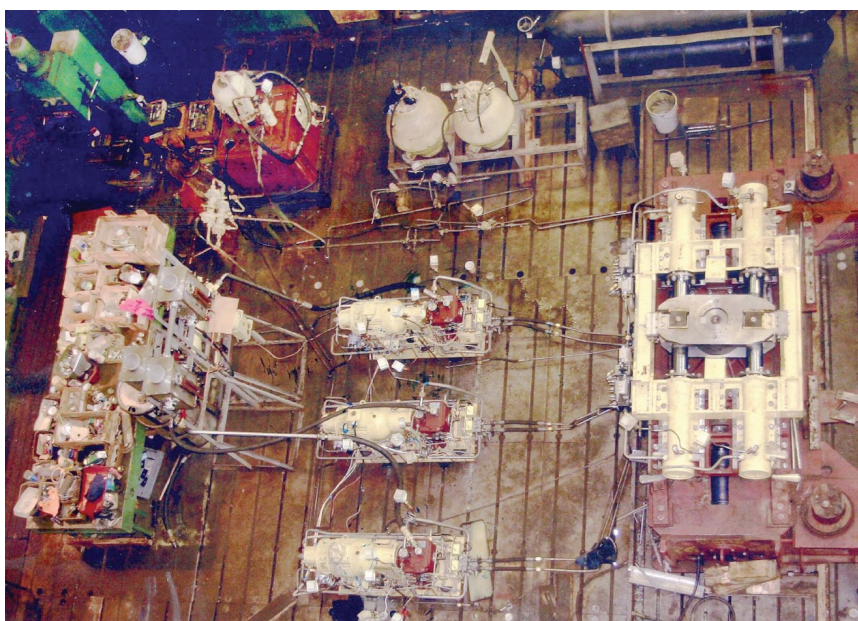
Рулевая машина Р21М2 на испытательном стенде. Установлена на тяжёлом авианесущем крейсере «Адмирал флота Советского Союза Кузнецов»
