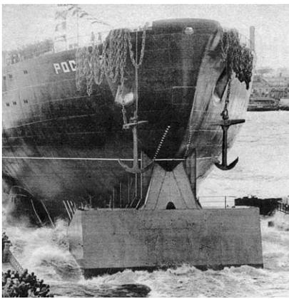
Рис. 21. Ледоотводные бульбы на атомном ледоколе «Россия»
