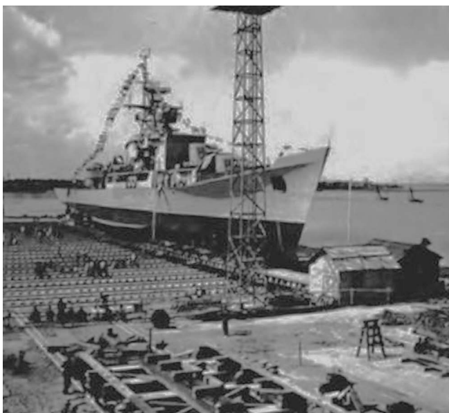
Спуск на воду фрегата пр.6601 на судостроительном заводе Hudong, Шанхай, 28 апреля 1956 г. Строительство осуществлялось путем сборки изготовленных в СССР секций корпуса и монтажа поставленных в КНР механизмов и вооружения
