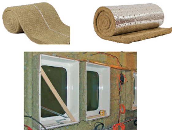
Рис. 1. Теплоизоляционный материал в процессе монтажа
