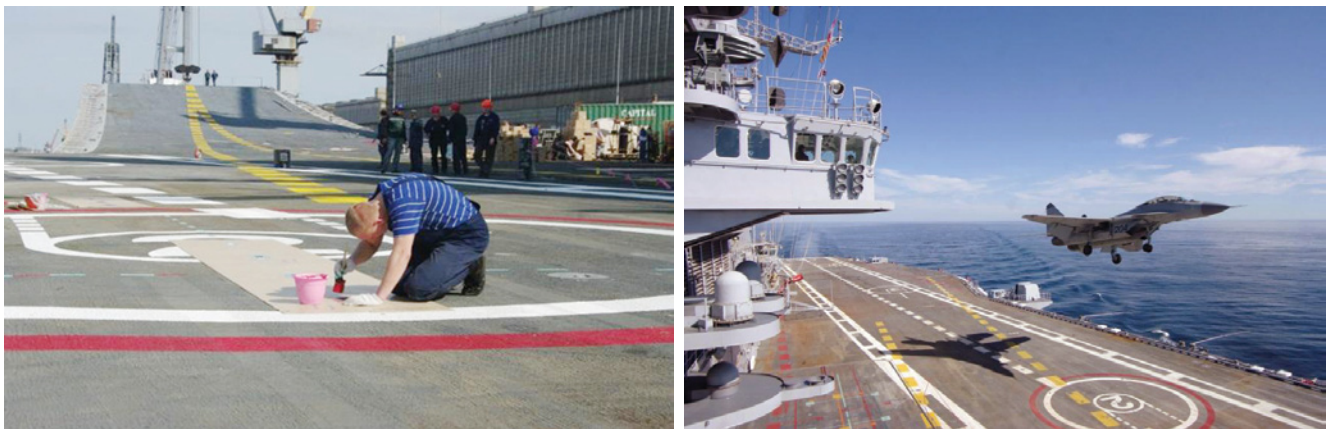
Рис. 7. Использование наливного палубного покрытия типа «ЭпоксиКоут» для восстановления палубы авианесущего корабля
