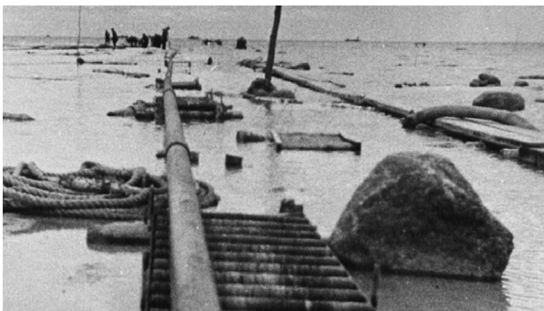
Прокладка трубопровода по специальной спусковой дорожке на рольгангах
