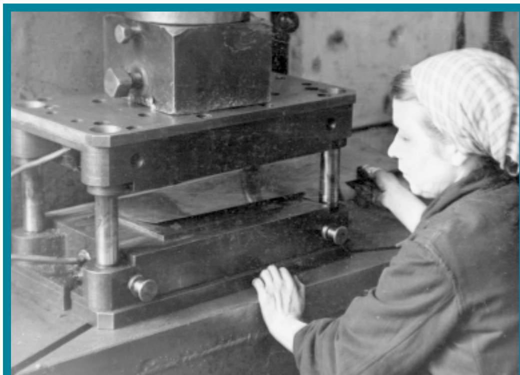
Штамповка пластическими штампами в электромагнитных блоках
