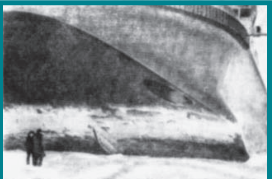
Рис. 1. Носовая оконечность ледокола «Мудьюг» (видны наклонная плоскость носа, ледоразводящий клин и труба якорного устройства). Фото науч. сотрудника ЦНИИ им. акад. А.Н. Крылова А.А. Карелина
